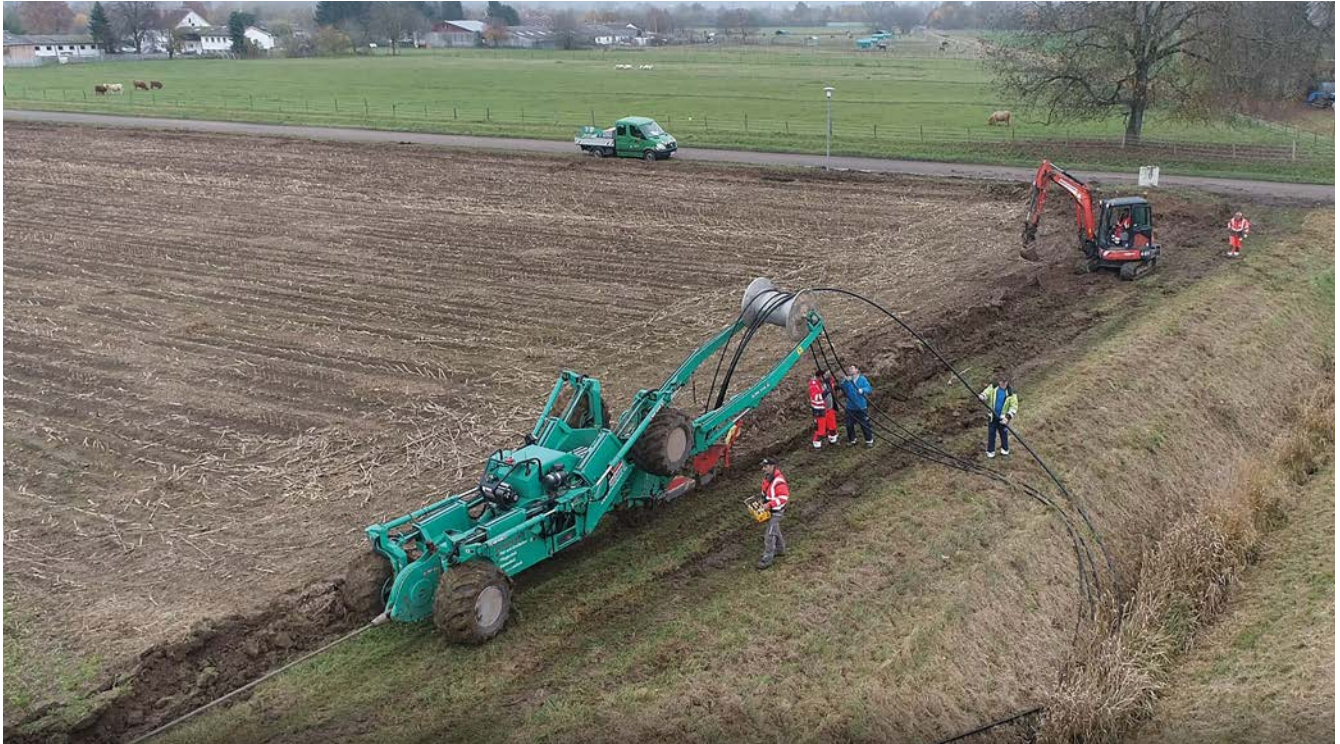
Baumaßnahme zur Verlegung der 20-kV-Mittelspannungsleitung unter die Erde mit dem Kabelflug
